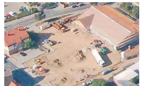
Aldi-Markt Bau Parkplatz
