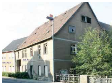
Eislebener Straße 1 / 2 vor dem Abriss
