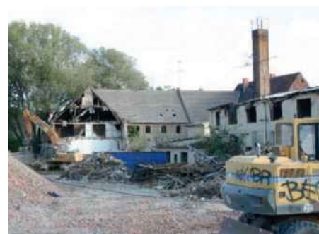
Eislebener Straße 1 / 2 in der Abrissphase
