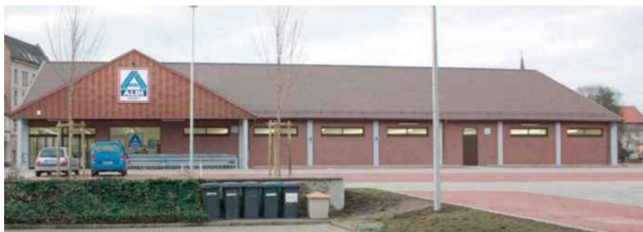
Die fertige Aldi-Kaufhalle im Dezember 2005
