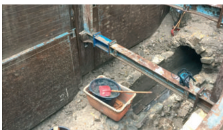
Einblicke in den Mischwasserkanal
